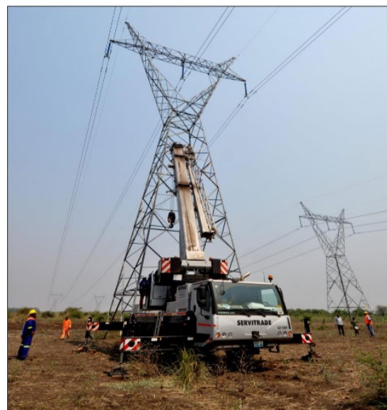
Рисунок 36: Пример процесса сборки башни (источник: http://csccon.co.za/ и EDM)
