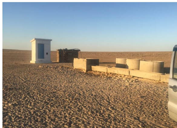
Рис. 57: Водопроводные станции (Источник: посещение площадки "Juru Energy")
