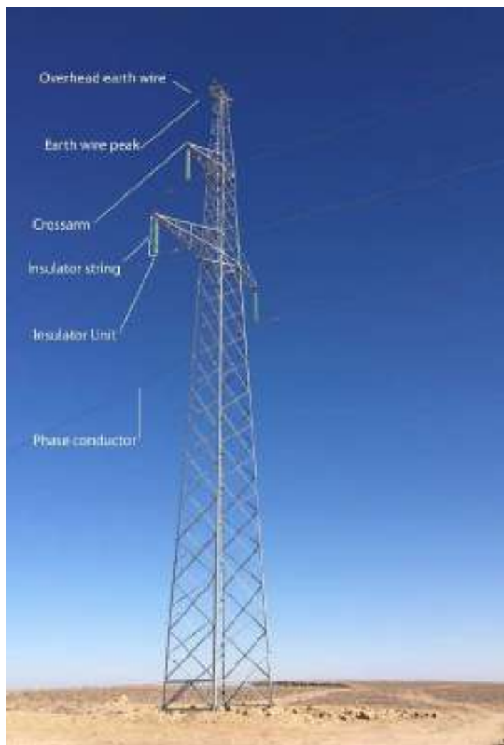
Рис. 5 Компоненты ВЛЭП (Источник: Juru Energy):
